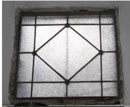
Az eredeti alagsori ablak és a megőrzött ablakosztása a kibontásra kerülő nyílászárón
